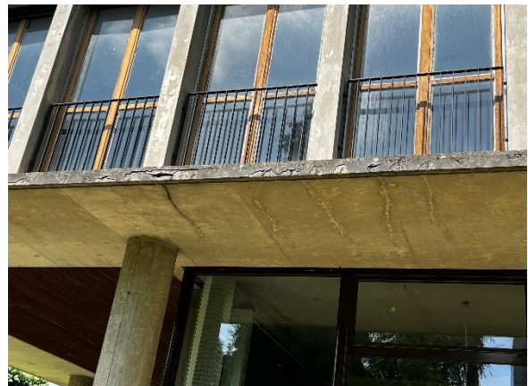
Photo 10 : Fissures accompagnées des traces d'infiltration – Façade Ouest
