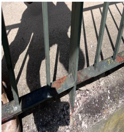
Photo 13 : Corrosion sur garde-corps – Façade Ouest
