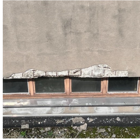
Photo 26 : Epaufures de béton et armatures apparentes corrodées – cour centrale
