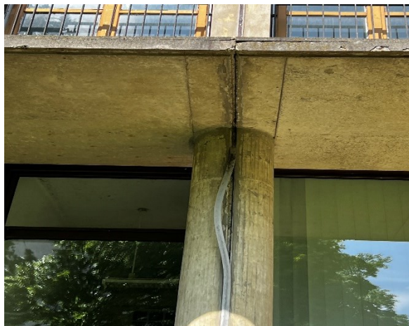
Photo 14 : Joint de dilatation dégradé – Façade Ouest
