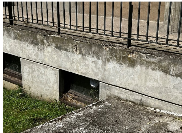
Photo 12 : Traces de moisissures et béton épaufré – Façade Ouest
