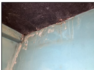
Infiltration au niveau du coin du bâtiment (zone sensible)
