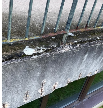
Photo 2 : éclats de béton & aciers apparents et corrodés – Façade Est
