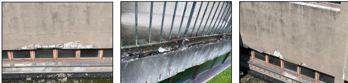
Épaufrures de béton, avec armatures apparentes et corrodées + corrosion au niveau des garde-corps
