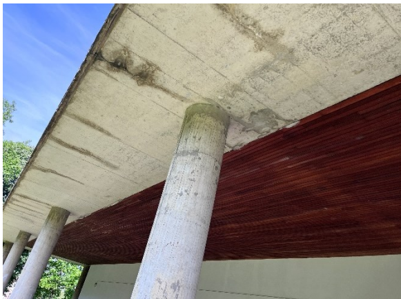
Photo 9 : Fissures accompagnées des traces d'infiltration – Façade Sud
