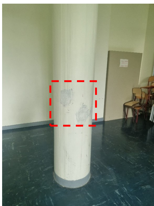
Rebouchage après des sondages destructifs
