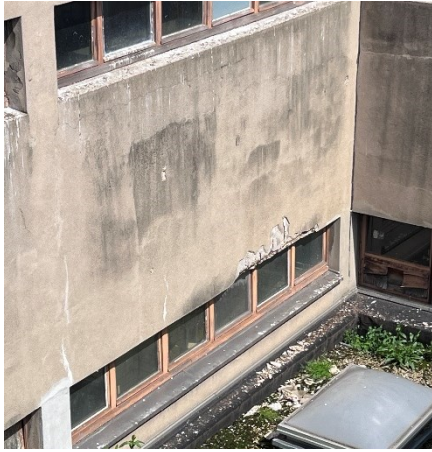
Photo 25 : Epaufures de béton et armatures apparentes corrodées – cour centrale
