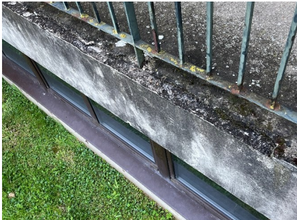
Photo 3 : traces de couleur rouille & moisissures – Façade Est
