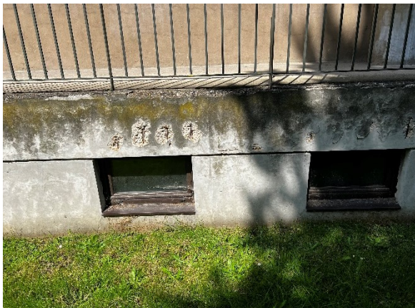
Photo 11 : Eclats de béton généralisé avec aciers dénudés – Façade Ouest
