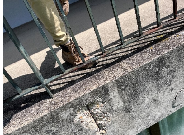
Photo 8 : Corrosion sur garde-corps – Façade Sud
