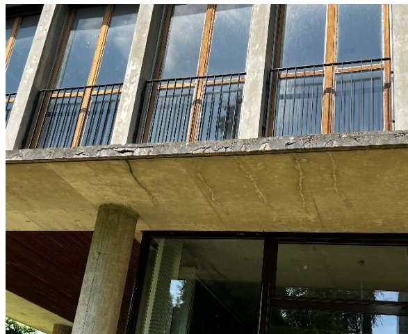
Photo 6 : Efflorescence apparue sur les fissures en sous faces du balcon– Façade Est
