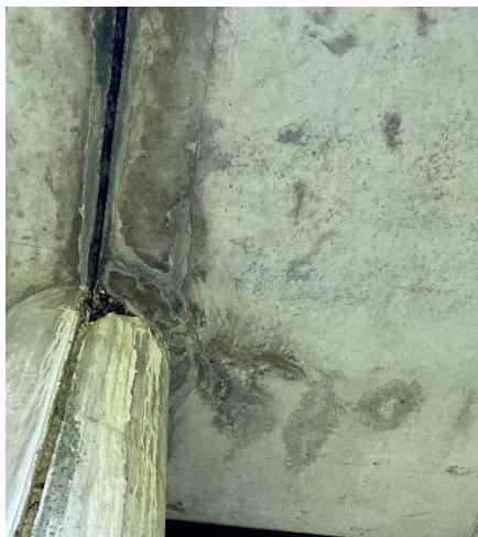
Photo 5 : Dégradation de joint de dilatation – Façade Est
