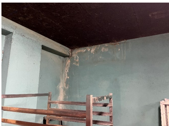
Photo 15 : Traces d'infiltration d'eau – Sous-sol
