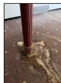
Infiltration d'eau au niveau d'une descente EP
