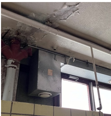
Photo 21 : Traces d'infiltration d'eau – 2 ème Etage
