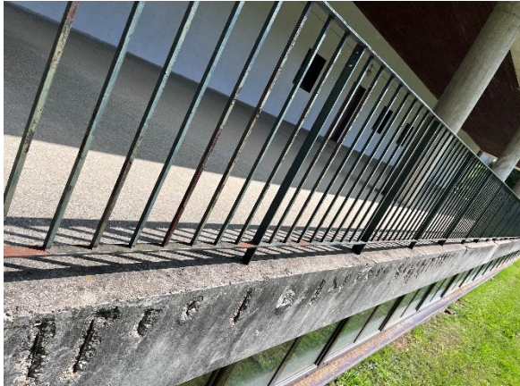
Photo 7 : Eclats de béton généralisé – Façade Sud
