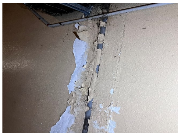
Photo 16 : Joint de dilatation dégradé & traces d'infiltration d'eau – Sous-sol
