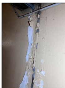
Infiltration au niveau d'un JD
