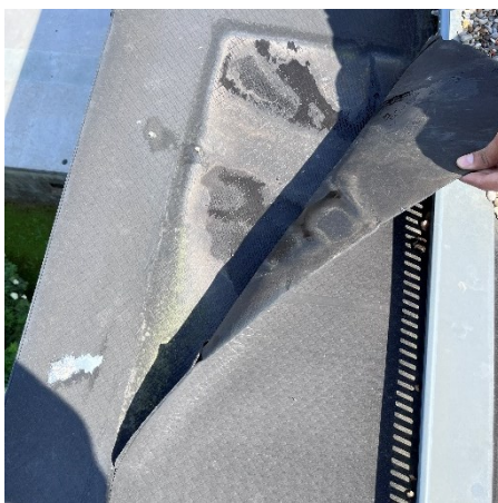
Photo 24 : Décollement de la membrane d'étanchéité – Terrasse
