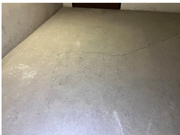
Photo 17 : Fissures sur dallage – Sous-sol
